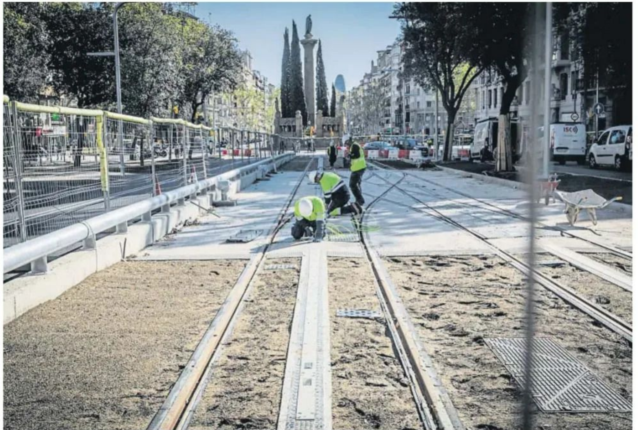
Operarios trabajando en la instalación del sistema de alimentación sin catenaria en el nuevo tramo por la Diagonal
